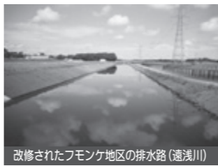
改修されたフモンケ地区の排水路（通浅川）
